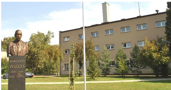
siedziba Poradni po termomodernizacji - 2016r.
