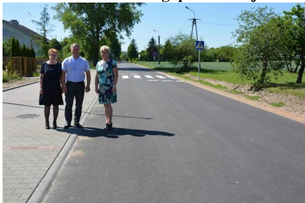
przebudowana droga w m. Gzy
