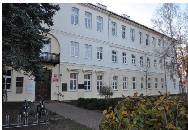
budynek LO im. P. Skargi po remoncie elewacji i dachu
