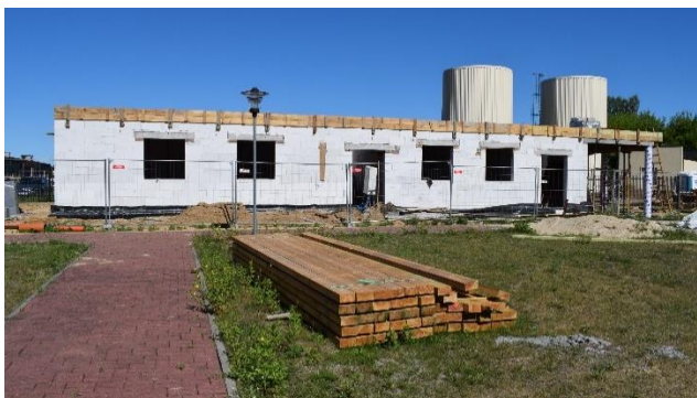
budynku garażowo- gospodarczego – XI.2018r
