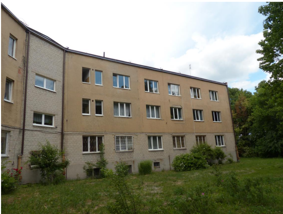
Fot. 2. Widok na ścianę budynku od strony parku.
