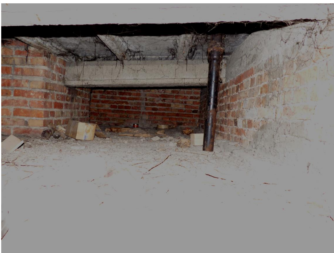
Fot. 4. Wnętrze stropodachu.
