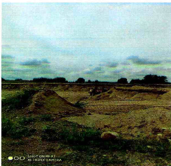
Kopalnia „Trzepowo XIII” gmina Pokrzywnica
